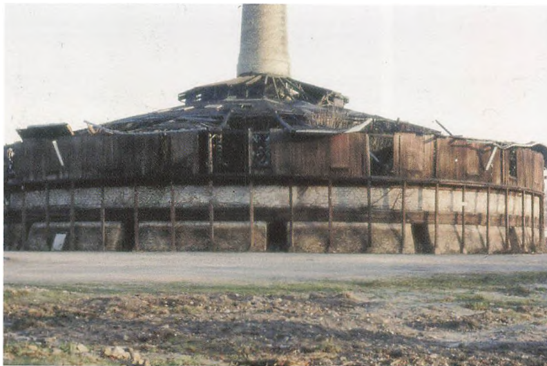
Ringovnen 1984 før renoveringen iværksættes
