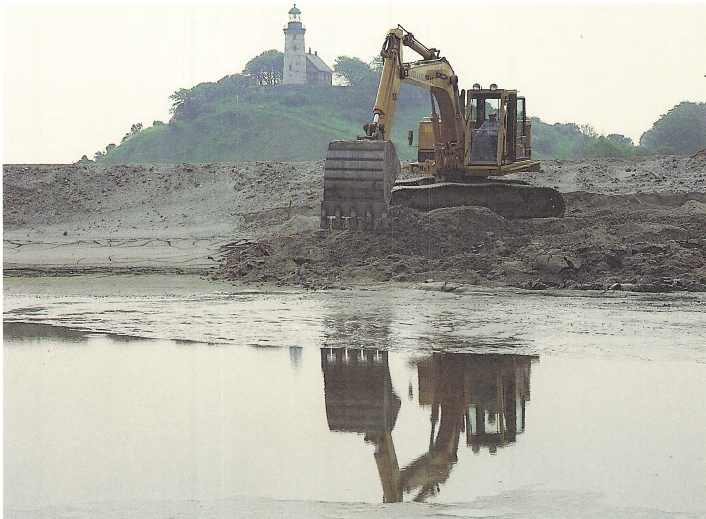
Sprogø i maj 1990. Gravemaskinerne er ved at færdiggøre den udvidelse, hvor togene skal køre ned i tunnellen mod Sjælland. Polfoto.
