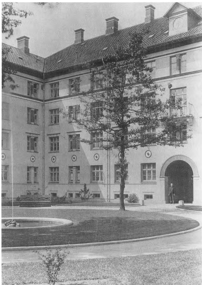
Fig. 40. Gården i Soldenfeldts Strifelse, set mod Ryesgade-stojen. Foto: Kunstakademiets Bibliotek, Samlingen af Arkitekturtegninger.
