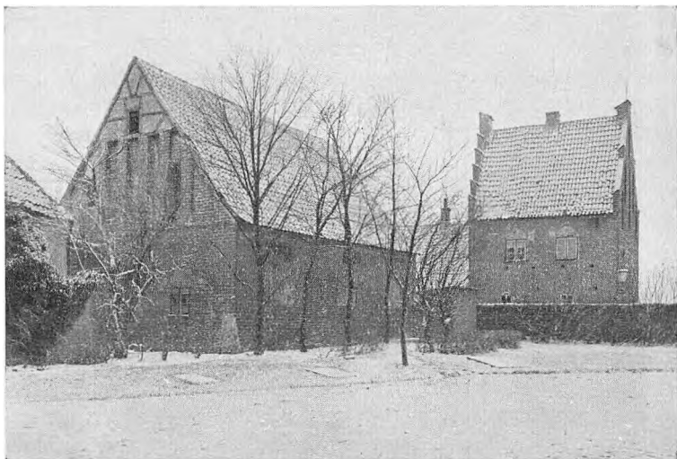
Fig. 12. Kirkeladen og stenhuset i Præstegade (før restaureringen)
