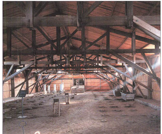
Ottende station i produktionsrundgangen: ringovnsloftet. I begge sider af gulvet tre rækker med dæksler, hvorunder der er huller ned til ringovnens brændingstunnel. Gennem disse huller kunne brænderne på ildens farve se, om temperaturen var høj nok, og om der var brug for at hælde mere kul ned. Med håndtagene i gulvets centerakse styredes blandt andet udtrækket til skorstenen. I 1930'erne blev brændingen delvis automatiseret med såkaldte kulstokerfyr, der ses bagest til venstre. Til højre to trækasser til opbevaring af kul. Foto: Ole Meyer. 2002.
