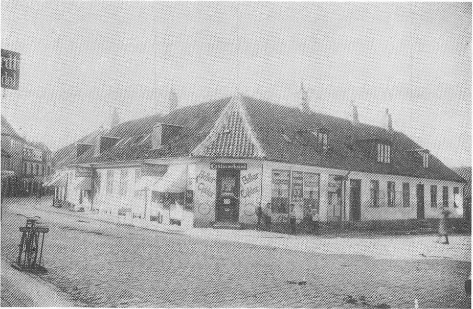
Kopi efter glasnegativ fra omkring år 1900, som viser Slotsgade set fra Torvet i Hillerød
