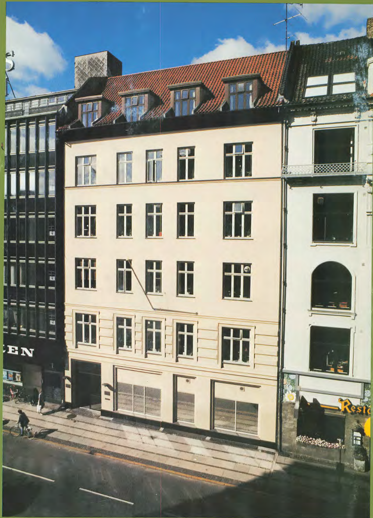
CS-huset, Trommesalen 3, København. (Foto: Peter Eilertsen)
