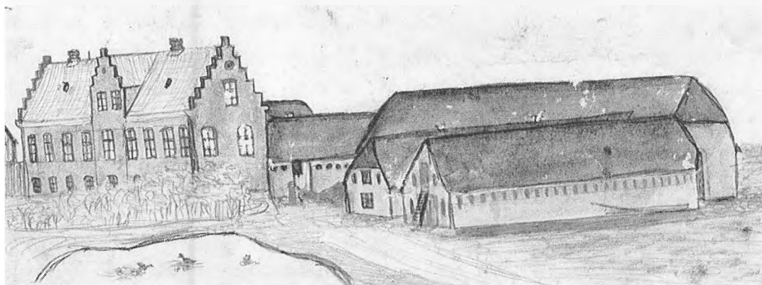
Vandborg Vestergård i 1874, antagelig tegnet af forpagterens datter. Niels Buch Breinholt byggede det pompøse stuehus med takkede gavle til sin hustru Anna som en kopi af hendes barndomshjem, Visby Hedegård ved Tønder. De lange, stråttækte udlængere var i mere traditionel vestjysk byggeskik. Blyants-tegning med vandfarve, bagpå skrevet: Til Fader fra Maria. (Lemvig Museum).
