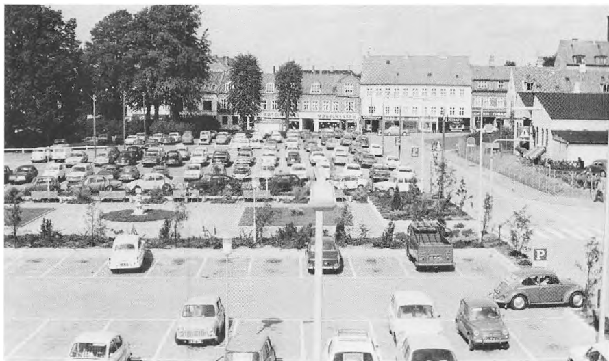
H. P. Hansens Plads og Korsgade set fra »Korsgadehus». Det gamle Ting- og Arresthus er endnu ikke fjernet. - Lokalh. arkiv.
