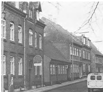
Stenstuegade nr. 46-36 efter at tagvandsnedløbene er ført til den underjordiske kloak. - Lokalh. arkiv.
