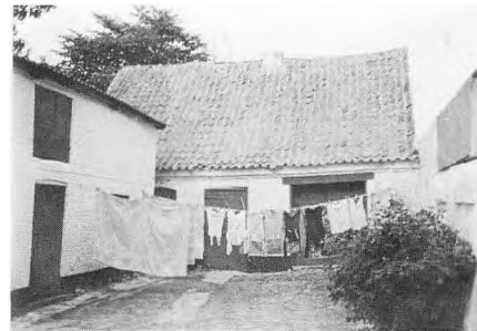
Baghuset til Stenstuegade nr. 42. I porten havde Pilemann sit slagteri, og i den vestlige halvdel var der hestestald. - Lokalh. arkiv.
