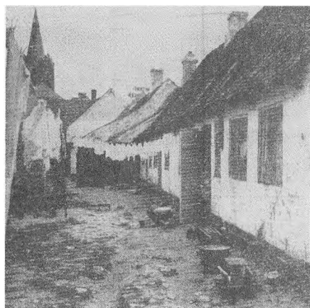
Gårdspladserne til Stenstuegade nr. 20-26 umiddelbart før nedrivningen af ejendommene. - Lokalh. arkiv.
