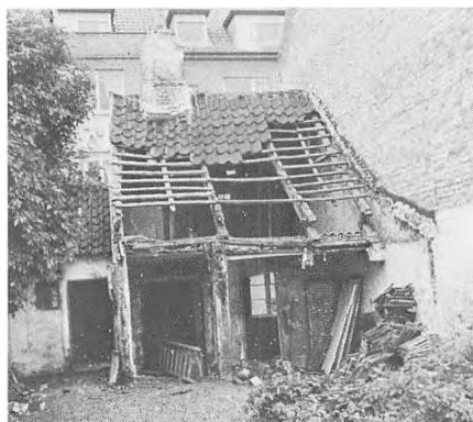
Stenstuegade nr. 38, set fra gårdsiden i 1954. - Lokalh. arkiv.
