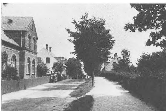
Lundevej før bommene faldt, og denne stille vej blev en pulserende færdselsåre. Vejbanen var, som det ses, i to „etager“. Billedet viser vejen ud for nr. 22 og 18.
