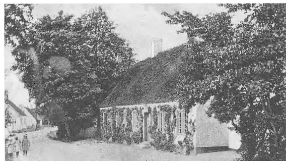
Rytterskolen i Gl. Ølstykke er bevaret i det ydre og er en pryd i den ellers idylliske landsby. Indtil 1956 blev bygningen benyttet til skole.
