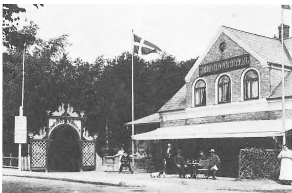
Jernbanehotellet med fortovsrestaurant og lysthave. Bygningen var faretruende skæv, gulvene ligeså, hvorfor det kunne hændes, at der var gæster, som mistede balancen.
