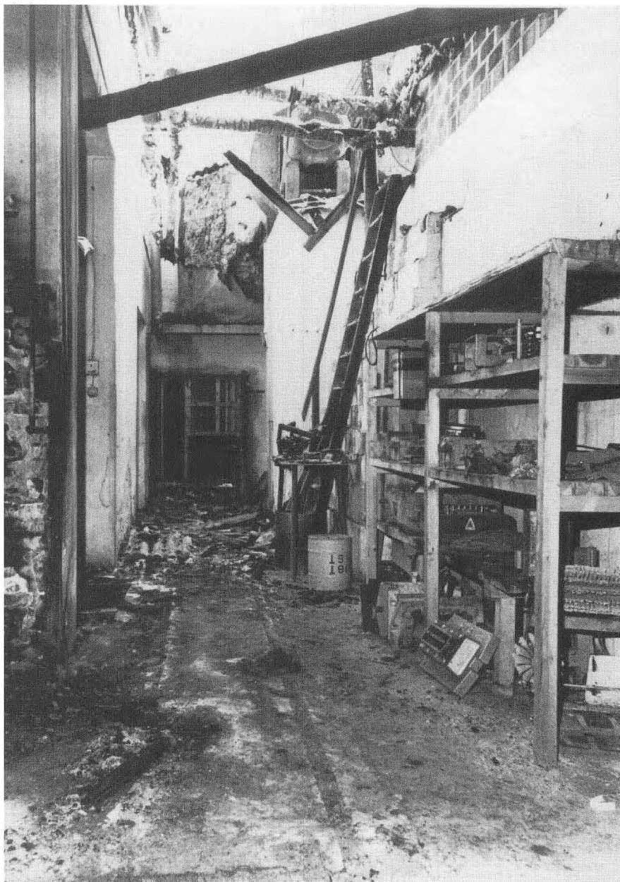
Her er et andet billede af maskinhuset efter branden, øverst i billedet skimtes resterne af den store blæser og el-motor, hvor branden opstod, og til højre står reolen med alle formene.
