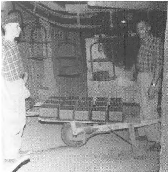
Her trilles der sten fra kredstransportøren, det er Karl Erik Krogh der lige er blevet færdig med at læsse sin bør. Til venstre står Preben Jensen og venter på, at det skal blive hans tur til at læsse.
