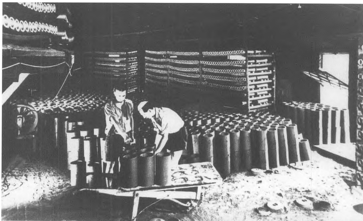
Her trilles der 6" rør på Ringovnen, hvor de bliver sat oven på hvælvingen mellem fyrrullerne, som det ses blev de sat på højkant med to lag oven på hinanden. I forgrunden er det Lindy Christensen og Anton Koza, der er ved at læsse rør af fladbøren. På hylderne i baggrunden er der blevet sat 2" rør ind. Øverst til venstre er det 3" rør, alle rør over 3" blev sat på højkant, de kunne ikke tåle at ligge ned, så mistede de faconen.
