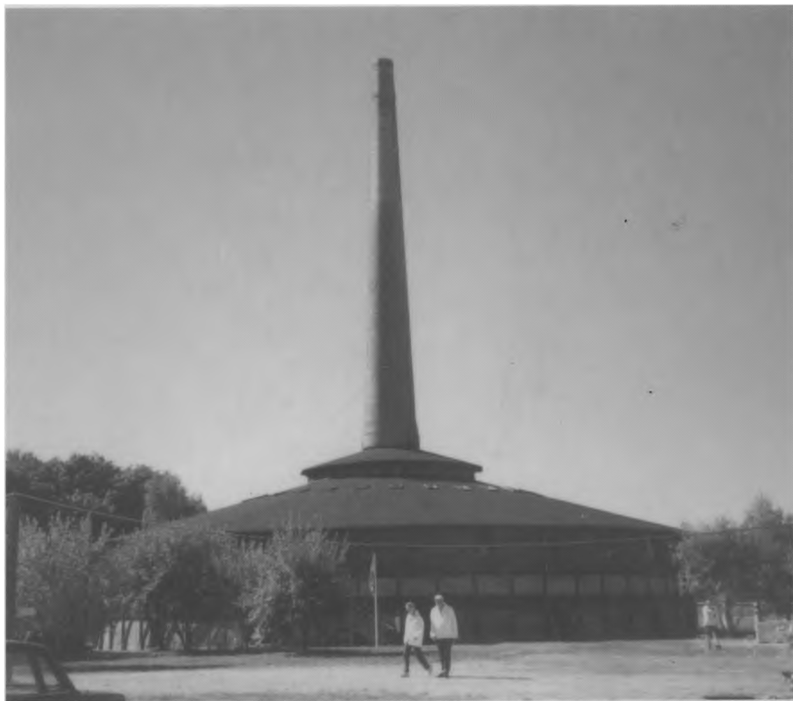
Ringovnen på Nivaagaard Teglværk efter renovering, september 1996
