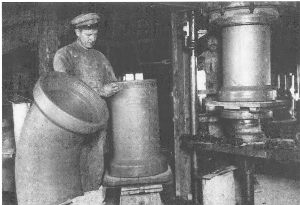
Her er vi kommet op på loftet over Langovnen, det er den store rørpresser vi ser til højre på billedet, hvor den er ved at presse et af de store mufferør, til venstre står Carl (Calle) Engstrøm og laver riller i et af de andre rør, manden bag ved rørpressen er hans far Carl Engstrøm, det var også på denne rørpresse, vi senere pressede de store 8-15" drænrør.
