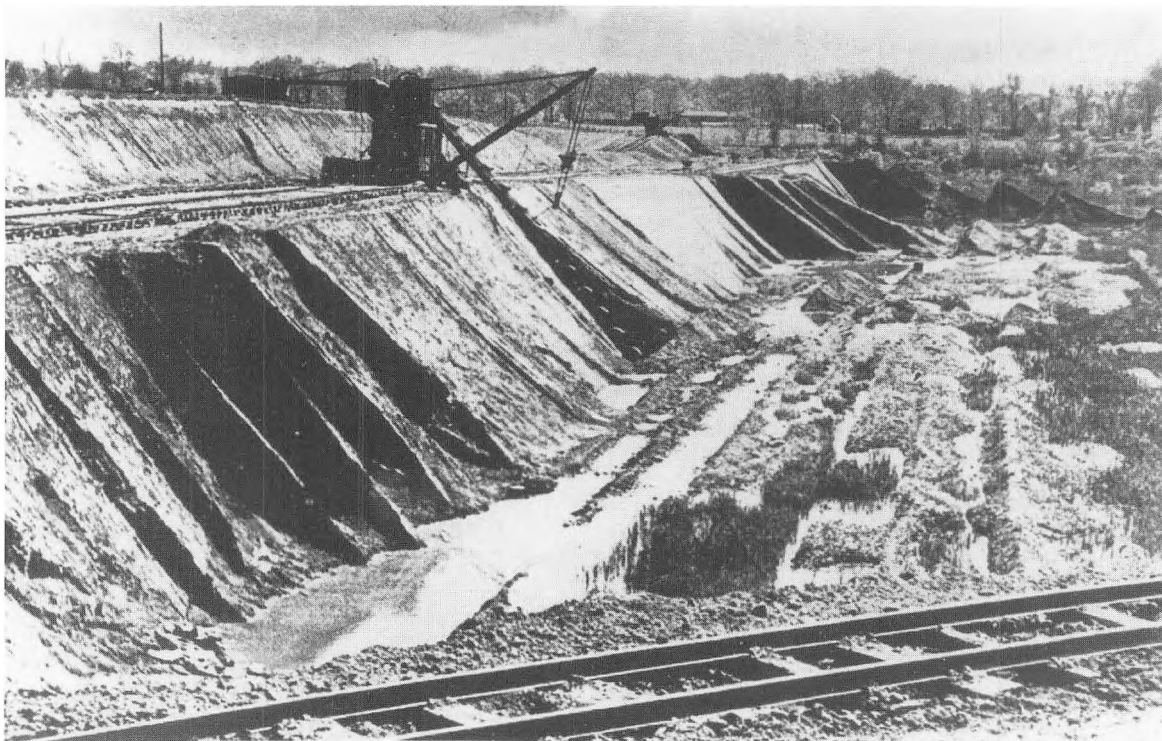
Her er lergraven, som den så ud omkring 1953-54, nederst i billedet ser vi afrømningsporet, og øverst lidt til venstre er det den store gravemaskine (spandekædemaskinen), der gravede leret til sten og rørproduktionen, og øverst og helt i baggrunden skimtes afrømningsmaskinen. Mellem de to gravemaskiner ses nogle af de tipvogne, der transportererede leret hjem til teglværket.
