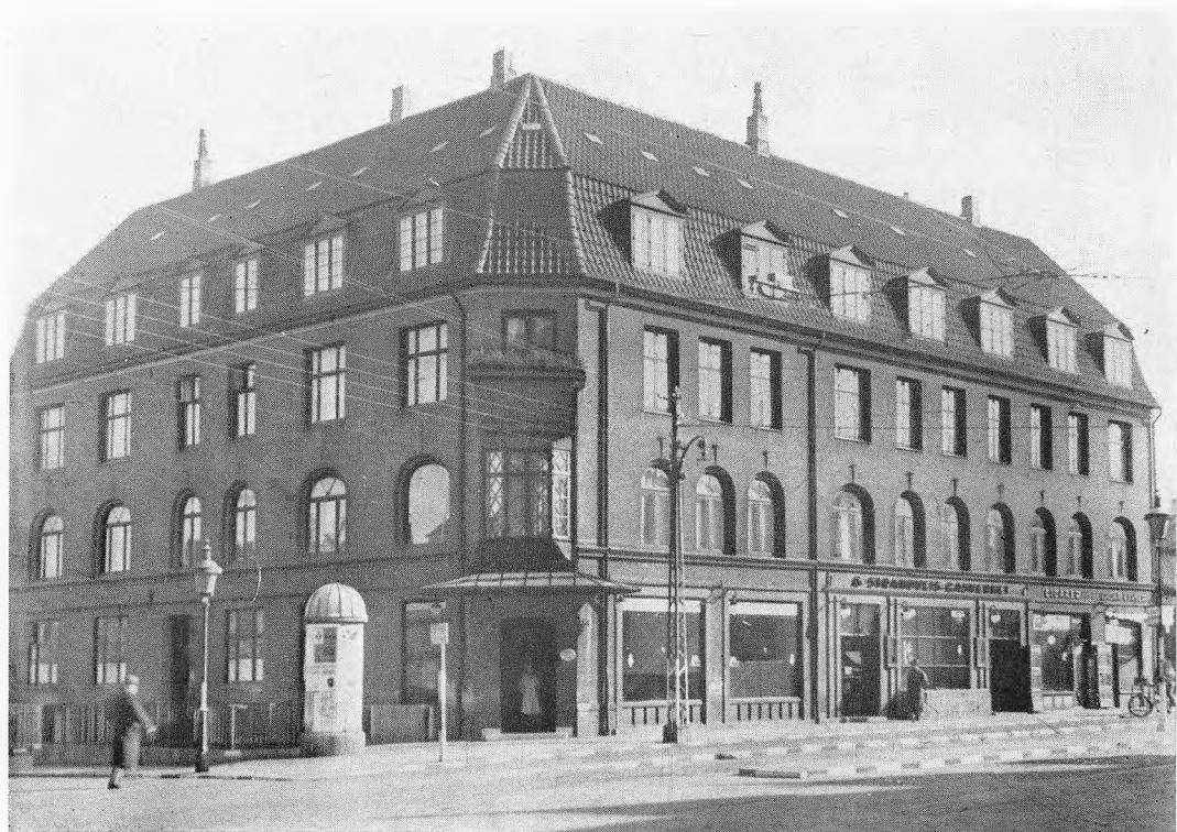
Ejendommen Strandvej 72 efter Ombygningen.
