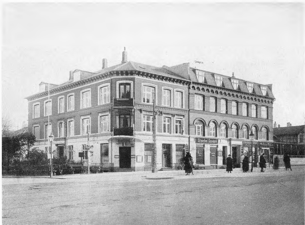
Ejendommen Strandvej 72 før Ombygningen.
