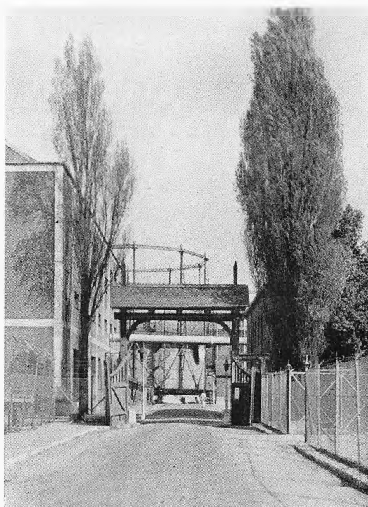
Hovedindkørsel til Gasværket indtil 1941.
