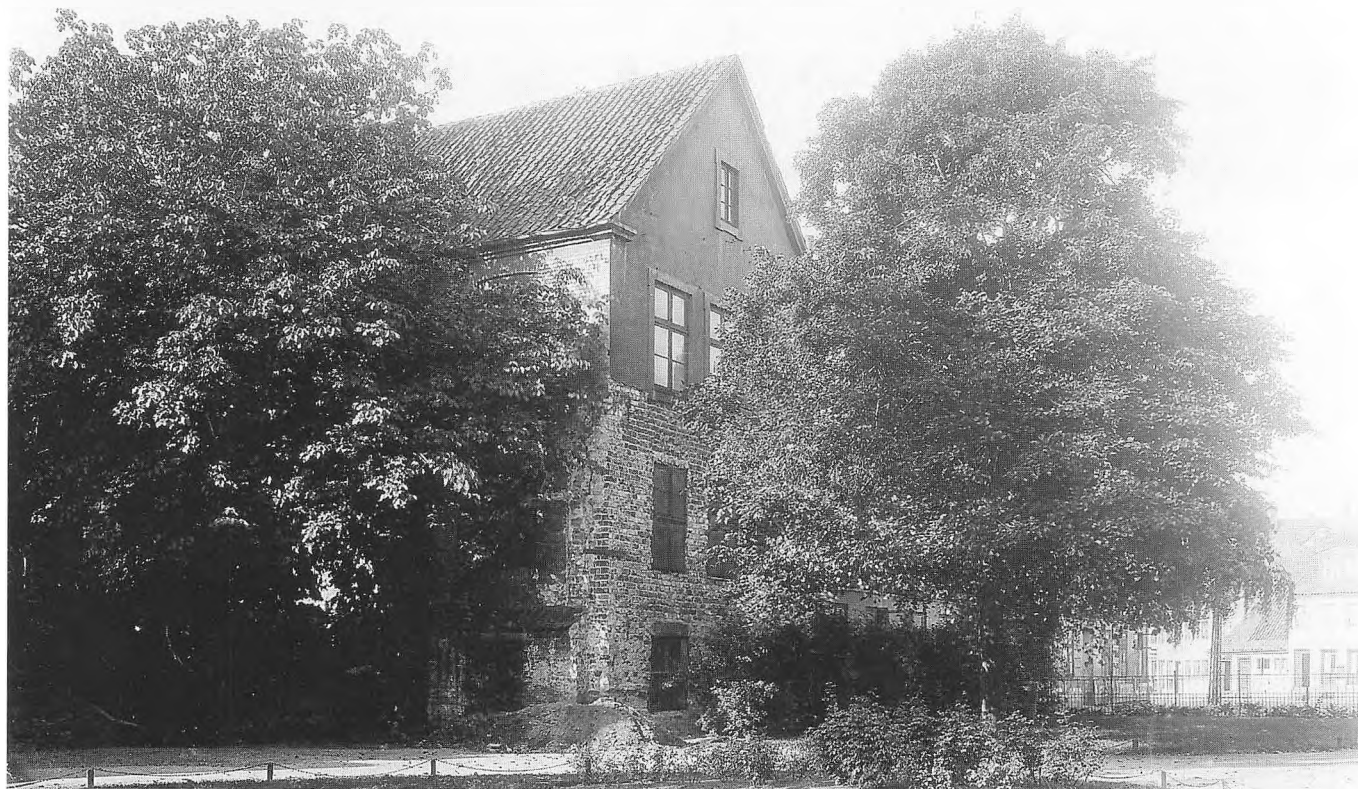
En del af klostrets vestfløj set inde fra kirkepladsen i 1915. På murværket ses tydeligt, hvordan bygningen har fået tilføjet endnu en etage. Den nordlige halvdel af bygningen blev formentlig nedrevet i 1600-tallet. Bygningen gik oprindeligt helt hen til kirken. Kun en lille del af den oprindelige klosterbygning er i dag bevaret mod syd (syd for det nuværende ligkapel) (Hugo Mathiessen fot., Møntergården).
