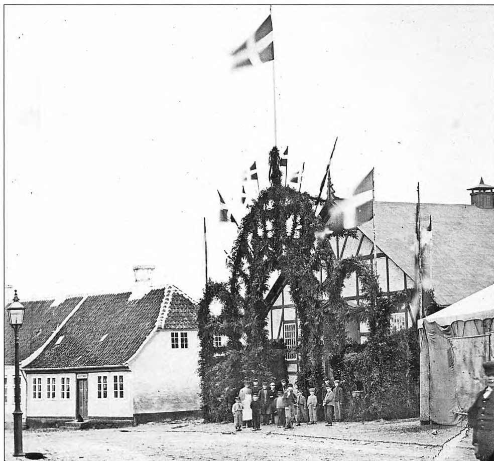
Fig. 47. Ridehuset ved Slotsgade ved eller kort efter indvielsen i 1866. Den store bygning blev bl.a. anvendt ved folketingsvalgene, der før havde været afholdt i borger- og friskolens gård. (Foto: A.C. Nielsen. Slagelse Lokalarkiv).
