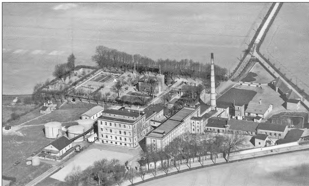
Fig. 142. Spritfabrikken på Valbyvej efter at vejen var ført uden om fabrikken. På billedet ses også et par jernbanevogne, idet det private Sporselskab havde etableret sporforbindelse til en række store virksomheder mellem stationen og Spritfabrikken, hvor sporet endte. Midt i billedet anes den store direktørbolig med eget tårn. (Slagelse Lokalarhiv, B 1822).
