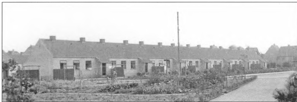
Fig. 164. Udover boligblokke med mange lejligheder byggede boligselskaberne også rækkehuse, hvor der hørte et lille stykke have til. Derfor blev disse boliger typisk placeret i nyudstykkede områder udenfor bymidten. Her ses rækkehuse på Baggensensgade, der blev opført 1949-1951. (Slagelse Lokalarbiv, B 50194).
