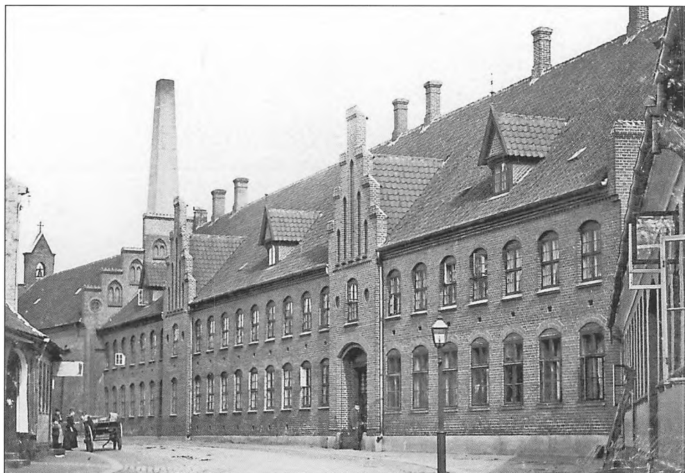
Fig. 77. Slagelse Hospitals nordfløj og Helligåndskirken i Bredegade. Den store skorsten hørte til det fyrrum med dampkedel, der blev indrettet efter 1896 i kompleksets middelalderlige del. Foto: N.F. Worm. (Slagelse Lokalkiv, B 2057).
