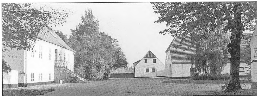
Fig. 157. Idagård blev i 1917 købt af frøavler Jens Hvidberg, der i 1941 overdrog gården til Idagårdsfonden. I 1844 brændte gården, og de fleste af bygningerne på billedet er fra 1845. Gården blev hårdt ramt af ekspropriationerne til motorvejen, dels fordi den mistede jorder og de tilbageværende blev delte, dels fordi der skulle etableres en helt ny adgangsvvej. (Slagelse Lokalkiv, B 51381).
