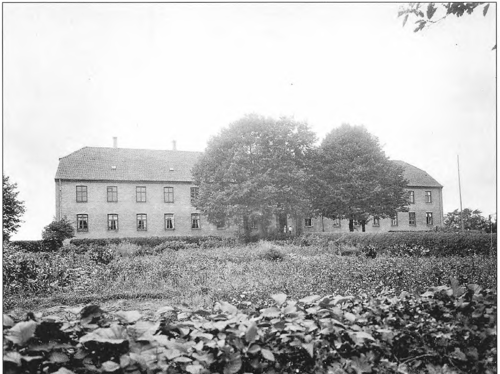
Fig. 74. Slagelse Købstads Forsørgelses- og Arbejdsanstalt i Herrestræde fra 1869, set fra bagsiden omkring 1920. (Slagelse Lokalarhiv, B 4839).
