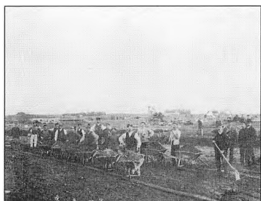
Udgravningsarbejder til fabrik og afsætning og udgravning af grund
