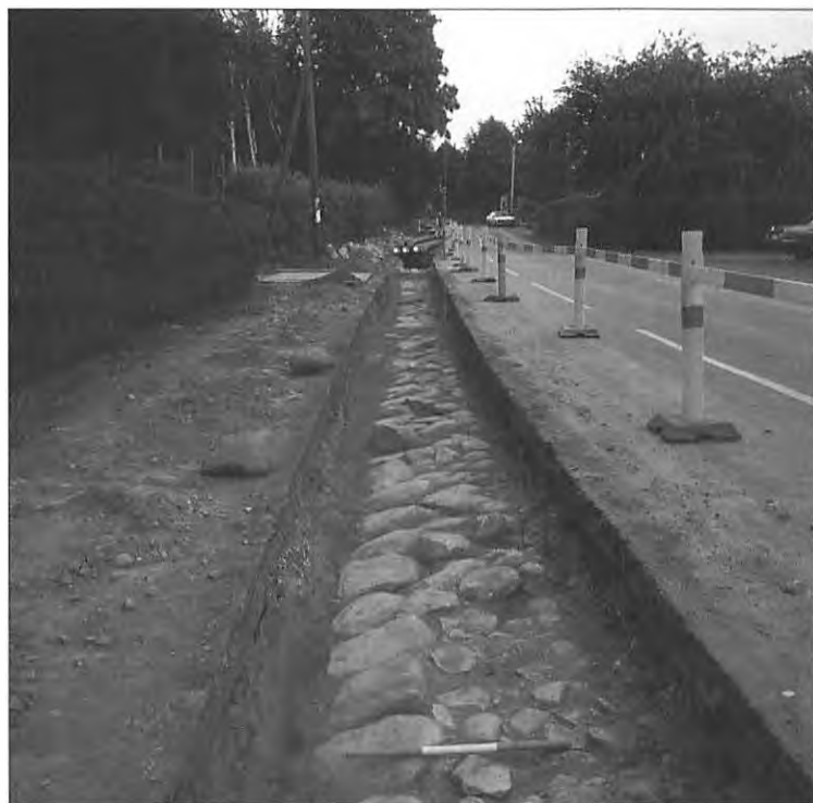
Den frilagte stenbro med store randsten og mindre udfyldningssten (Foto Fl. Beyer 2000).
