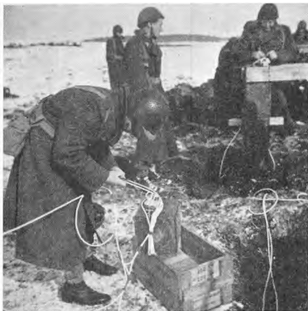
Klargøring til sprængning af pansergrav.
