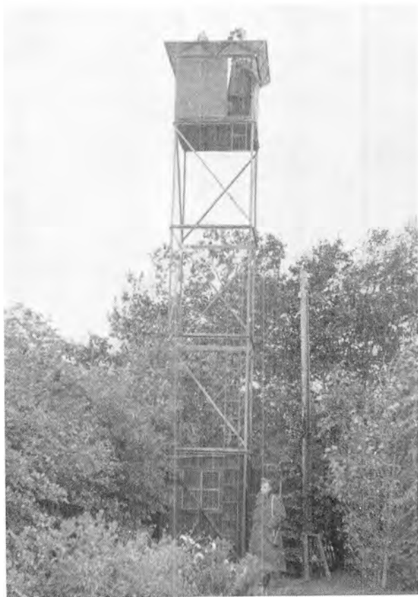
Luftmeldetårn af stål.
