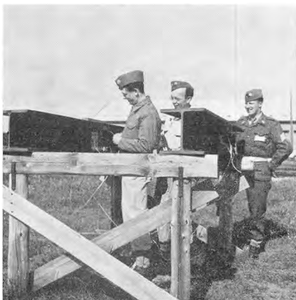
Forberedelse til sprængning af jernprofil.
