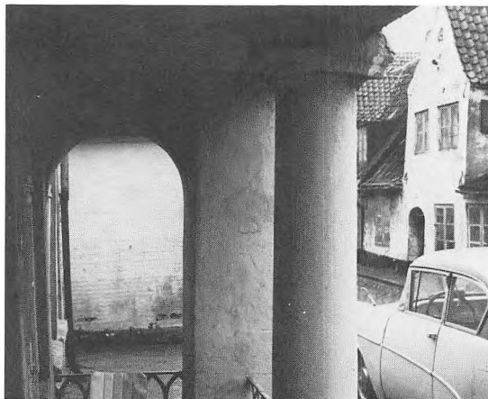
Et kig ud mellem søjlerne i den tidligere keglebanepavillon, senere svendekro, Slotsgade 40 mod nr. 39, der oprindeligt var en lille håndværkergård, men som ved nedrivningen 1974 var en elendig slumbeboelse. (Fot. P.D. 1974).
