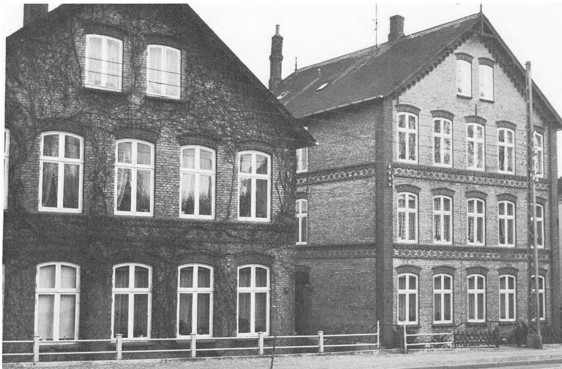
De to »kommodehuse«, Haderslevvej 20–22, opført 1898–1900 af bygmester C. Iversen. (Fot. P.D. 1974).
