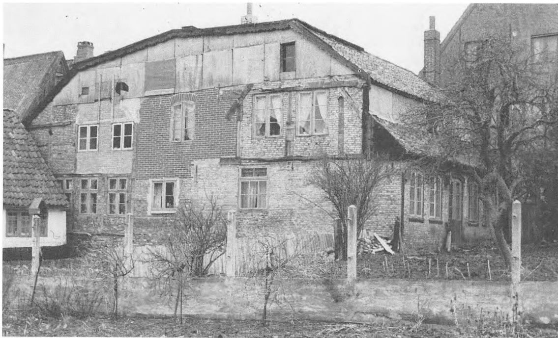
Nygade 47, henholdsvis parti af gården og bag- og sidehuset set fra syd. Man ser tydeligt bygningerne i gården, der var lappede og reparerede som et kludetæppe hos en fattig kone. Det utrolige miljø blev revet ned 1976. (Fot. P.D. 1974 og 1972).
