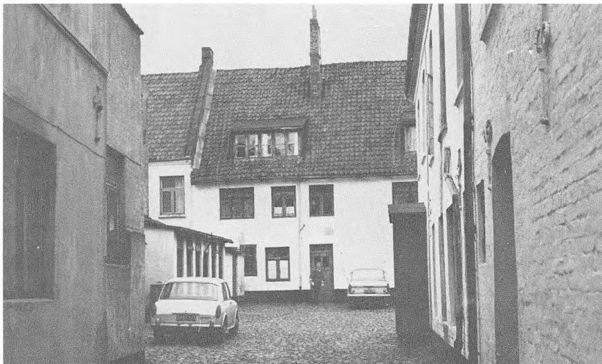
Nygade 45, gården set mod baghuset.
