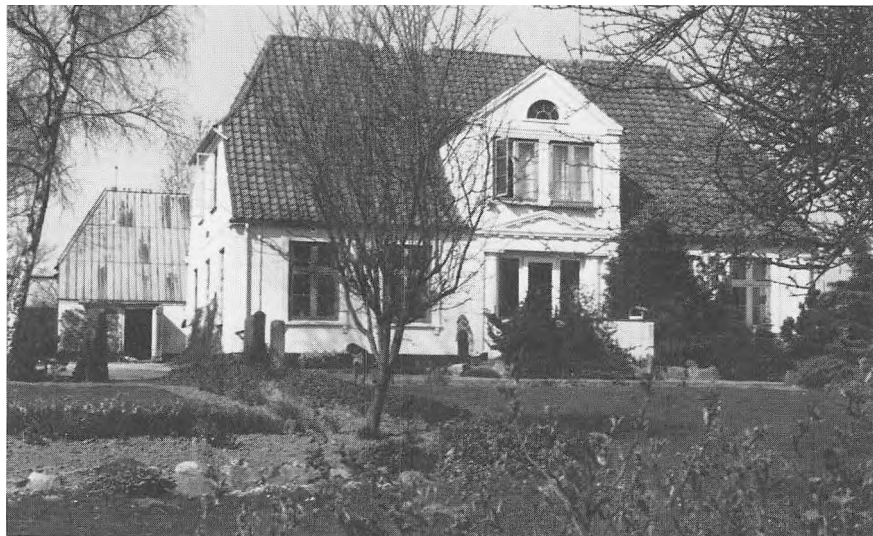
Kaptajns gård, Stollig, ca. 1855, Løjt S. (Fot. P.D. 1975).
