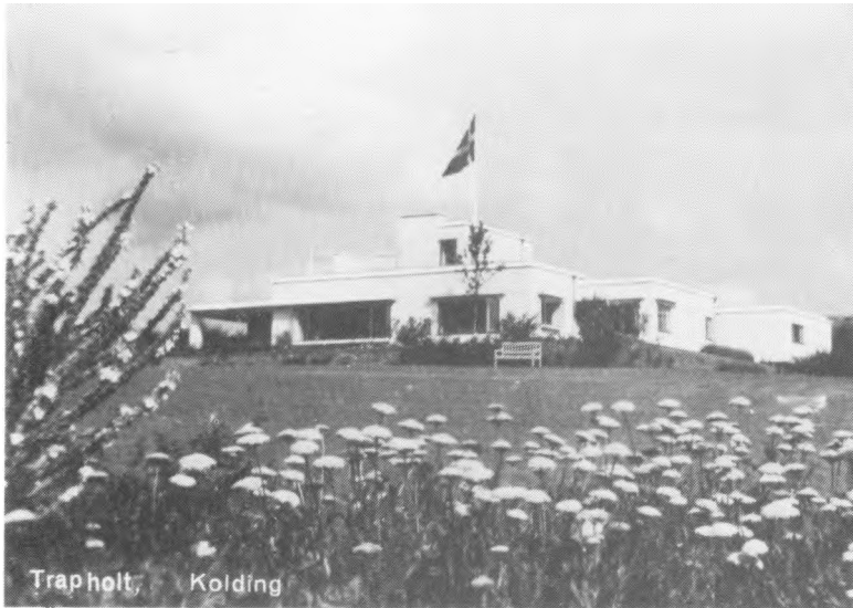
Murstenene var blevet misfarvet af at stå ved vejen, så da Trapholt var færdigbygget blev det bestemt, at det skulle pudses
