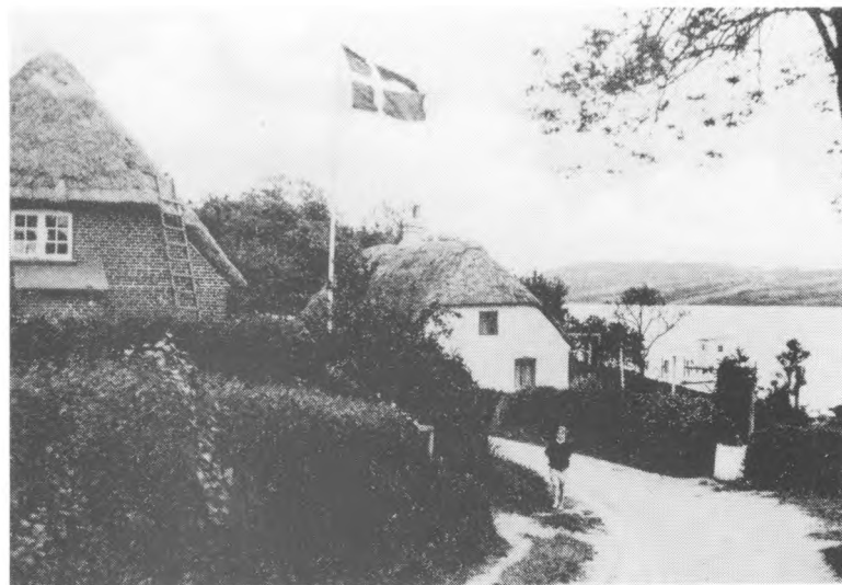
Strandhuseidyl. Mads Madsens og Andreas Weiles huse (Ægirsvej nr. 3 og 10)
