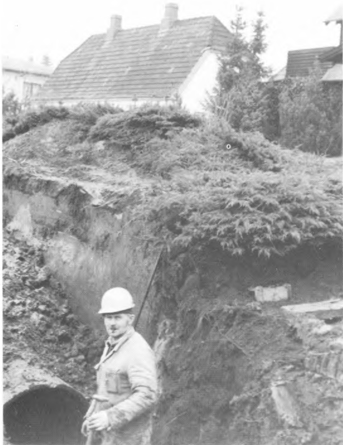
En meterdyb udgravning skulle give plads til den store kloakledning
