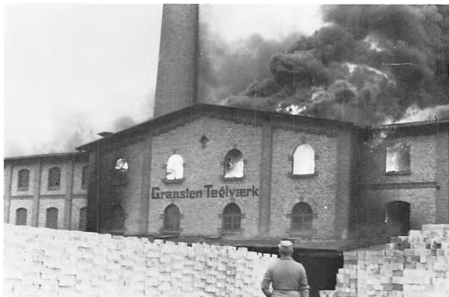
Fra branden 1960 på Gråsten Teglværk.
