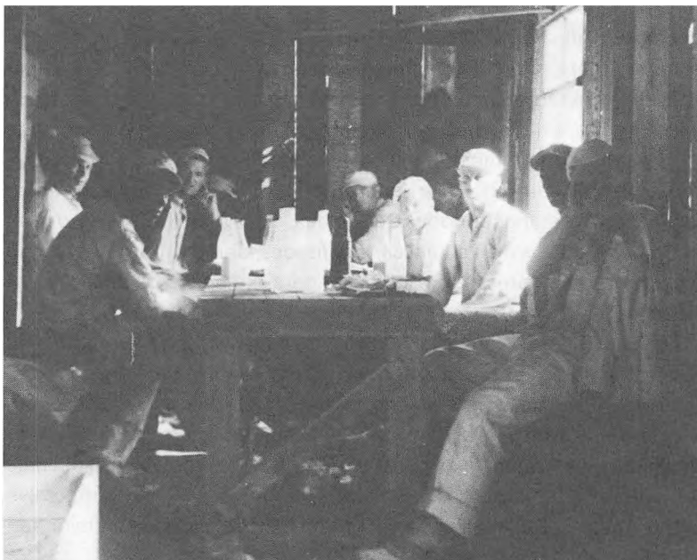
Murere holder frokostpause. Skurforholdene var primitive langt op i tiden. Her er der bygget et utæt skur af forskallingsbrædder.
