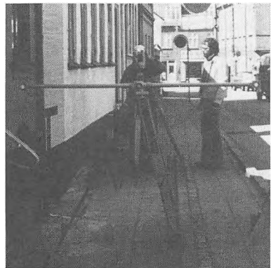
Fig. 10: Afstandsmåling m. basislægte.
