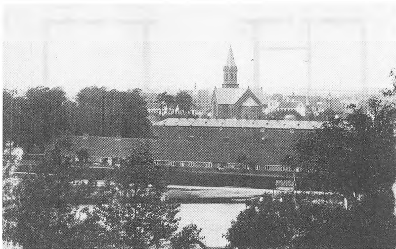
Foto af den østre længe indtil nedrivningen 1918. Den enkelte lejligheds tre vinduer ses tydeligt, mens det kan være svært at få øje på døren. Umiddelbart foran lå den kunstigt anlagte omladekanal. Bagved venstre længe ses, hvor tæt opad byen lå.
