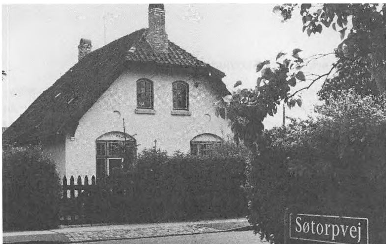
Hus på Dianavej i bebyggelsen Søtorp. Huset er relativt uændret med sine småsprossede vinduer, afvalmede tag og to skorstene. Kvarteret er i dag som helhed under stærk forandring, haverne er blevet frilagt og mange huse har fået skalmure, tilbygninger og nye vinduer. Lokalthistorisk Arkiv, Rødovre.
