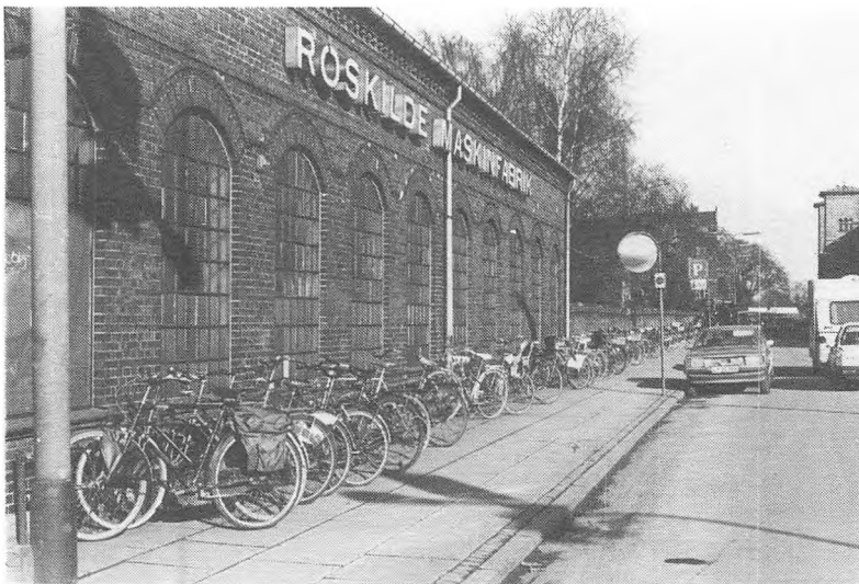
Roskilde Maskinfabriks façade til Jernbanegade. Foto: Bent Oslev 1987.
