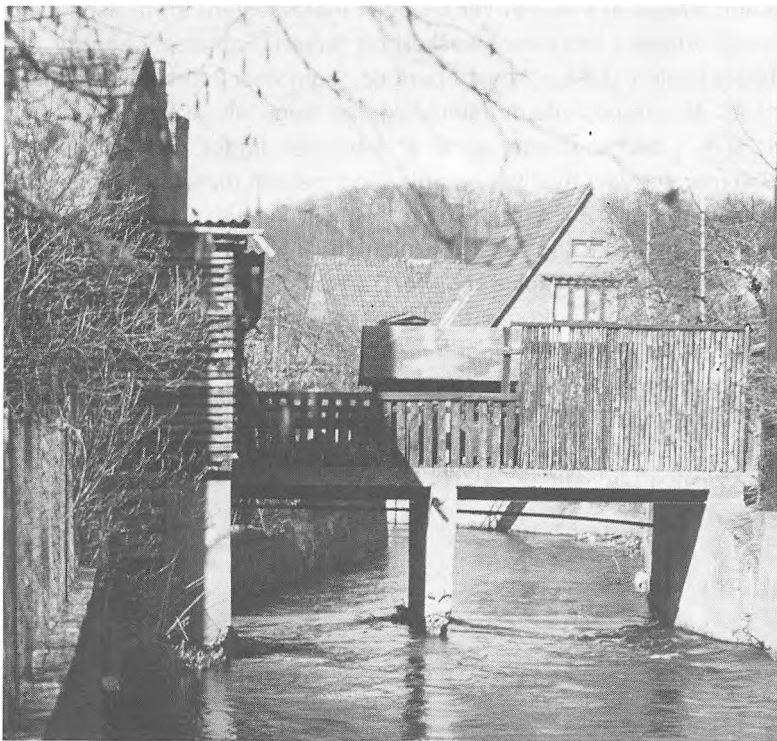
Opstemningen ved piskefabrikken Scandia er sløjfet, men turbinekammeret står tilbage.
