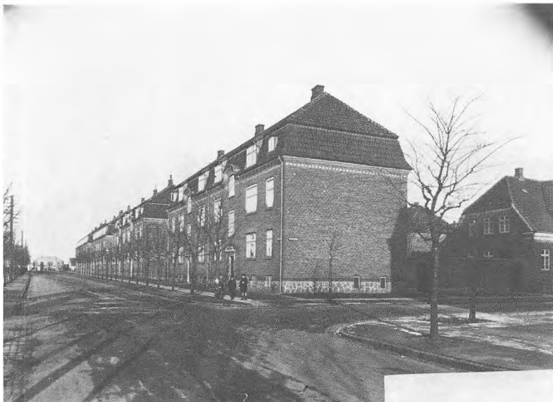
Arbejdernes Boligforenings første blok ved Østergade i Esbjerg, bygget 1917 med N. Chr. Nielsen som arkitekt. Ligheden med Vigerslev-husene er iøjnefaldende (Byhistorisk Arkiv, Esbjerg).
