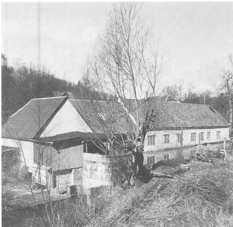
Elektromøllen. Møllekanal og turbinerum.
