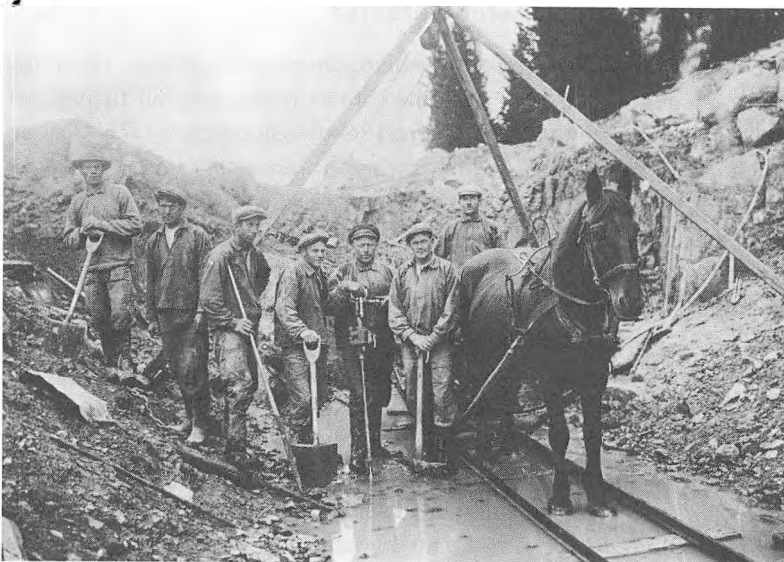
Anläggare i Uppland på 1940-talet. Under mellankrigsåren började arbetet mekaniseras. Här poserar en arbetare med sin pneumatiska bormaskin i kretsen av sitt lag.
