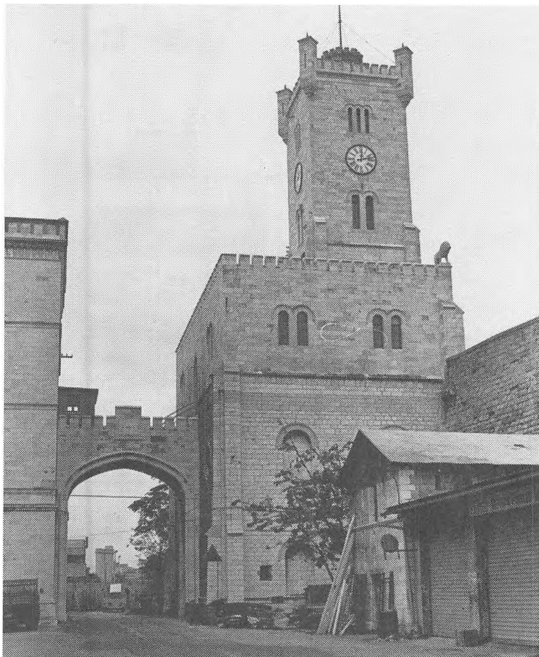
Trappehus og portbygning til administrationsbygning set fra øst. Til højre landevejsmuren og staldbygning. Foto 1984.
