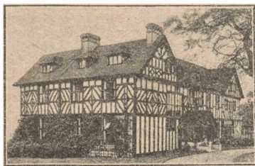
Engelsk Landsted. Det er ret nyt, men opført af Bindingsværk i gammel Stil.
