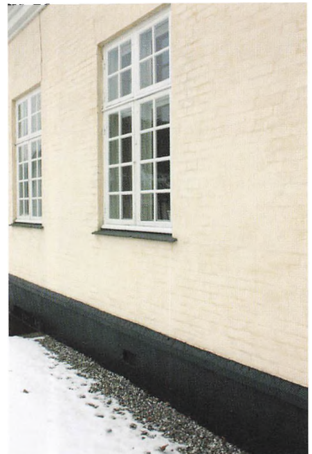
En vandskuret og kalket facade, hvor kalkens overflade står levende og varieret.
