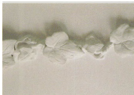
En stuk, der er udført til stedet af en dygtig stukkatør, er altid at foretrække frem for polystyren.
