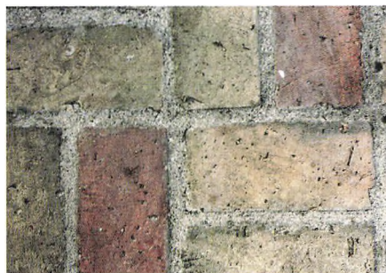
Teglgulv lagt på fladen i et fletmønster.
