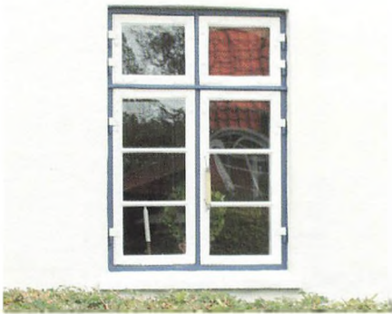
Et firerammed vindue med tværpost, overrammer og tofarvede vinduer med et såkaldt liggende rudeformat.
