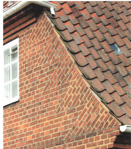
En muret gavl med såkaldte strømskifter langs med tagkanten – en fin håndværksmæssig detalje og en stor skam, hvis denne detalje blev sløret af en indfarvet facadepuds.
