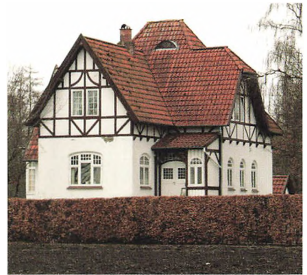
En nationalromantisk villa opført i bindingsværk og med mange forskudte tagformer. Askov, Syddjylland.
