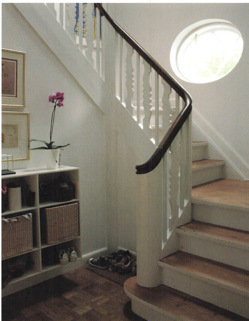
Kvartsvingstrappe med detaljer af mægler, håndliste og diagonalstillede balustre, 1936. Den 2den Bygmesterbog, 1941.
