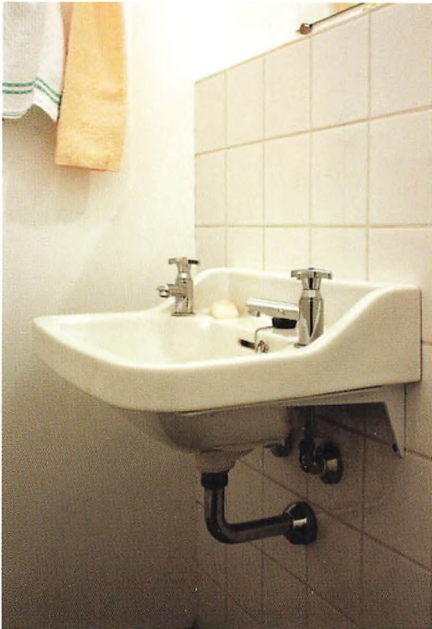
Hvide fliser er opsat bag håndvasken. Fliserne er nye, og håndvasken er den oprindelige, der blot er sat op igen med nye armaturer.
