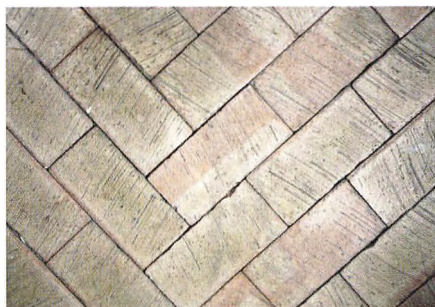
Teglgulv lagt på fladen i et sildebensmønster og med knasfuger.
