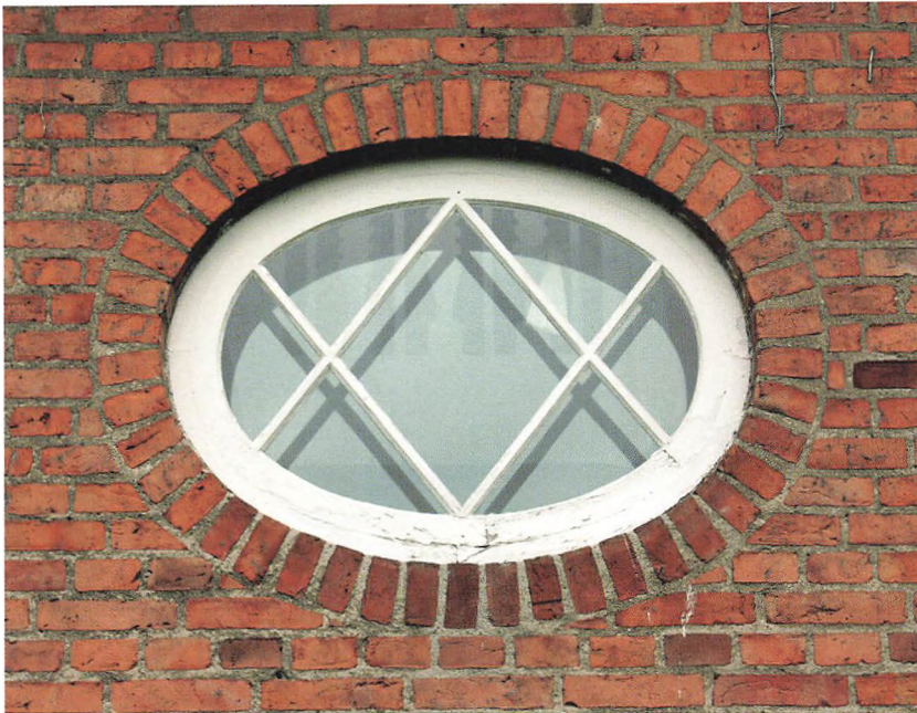
Blankt murværk med skræbefuge. Skræbefuger bruges mest til murværk af blødstrøgne sten.
