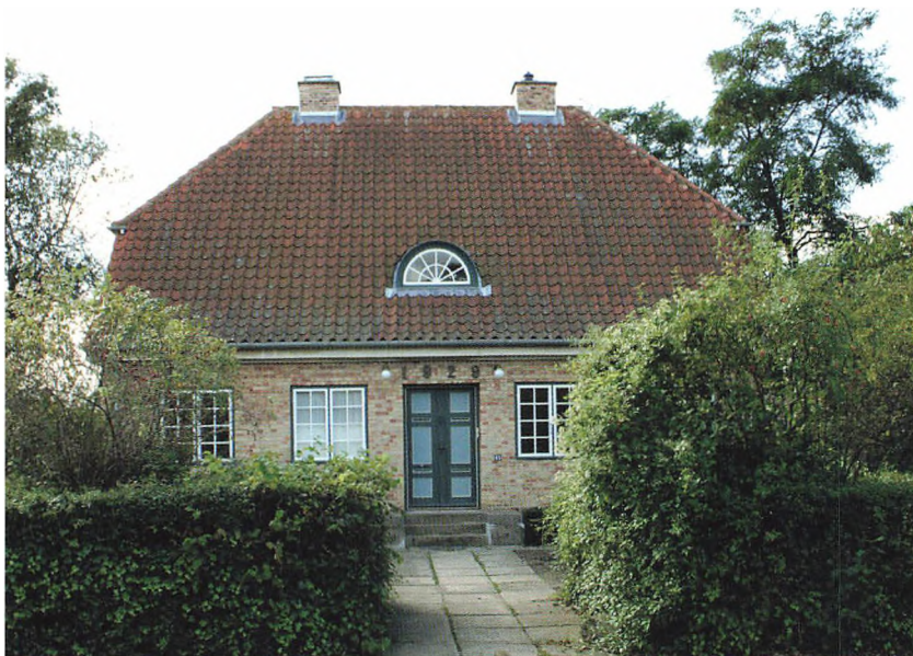
Betonfliser og grus er en klassisk materialeresammensætning – her brugt på havegangen foran arkitekten Marius Pedersens eget hus i Holbæk – nu Museum for Bedre Byggeskik med både hus og have som fint bevarede eksempler fra perioden.
