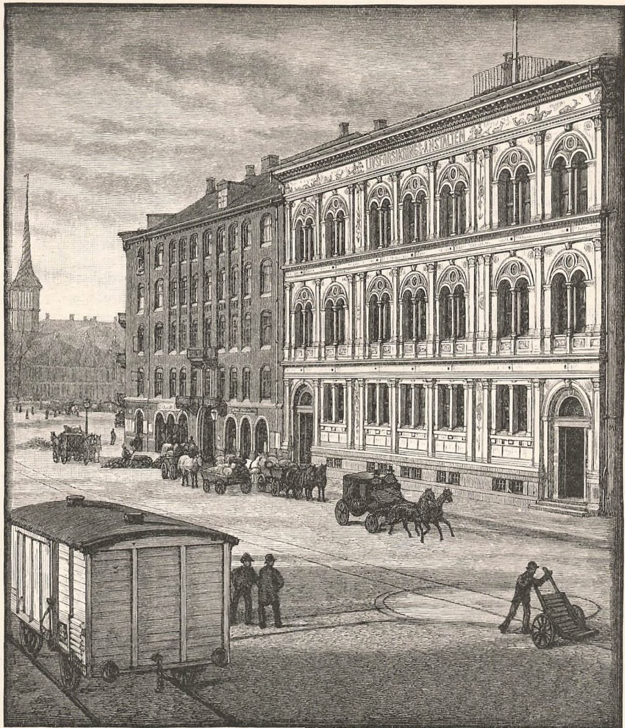
LIVSFORSIKRINGS-ANSTALTENS BYGNING I HAVNEGADE
