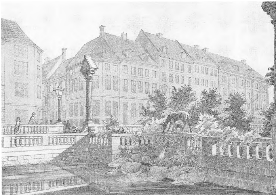
»Foreningen til Hovedstadens Forskønnelse«, der var stiftet 1885, søgte som en af sine første opgaver at faa gennemført en kunstnerisk udsmykning af Amagertorv og Højbroplads. I den forbindelse udarbejdede arkitekten Martin Nyrop i 1888 dette projekt til et blomstertorv, grupperet omkring en dekorativ fontæne.
