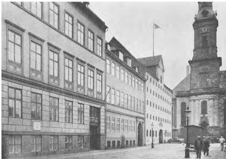
Grundtvigs Bolig i 1830'erne i Strandgade nr. 56, nu nr. 4. Grundtvig boede paa 2. sal i den midterste bygning. Huset i forgrunden er Tordenskjolds bolig. I baggrunden Jac. Holms store kornmagasin og Frederiks tyske kirke
