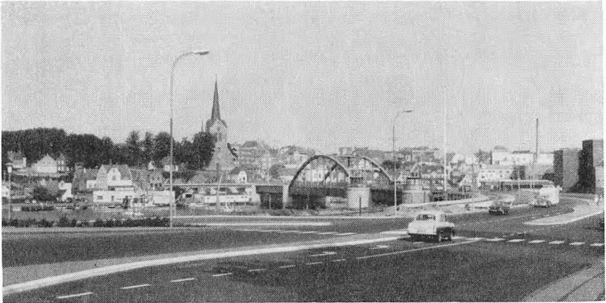
Fig. 10. Christian X's bro i Sønderborg. Broen er den eneste faste forbindelse mellem Als og Sundeved og som følge deraf meget stærkt belastet, idet både den lokale og den gennemgående trafik er nødsaget til at benytte den. En omkørselsvej ved Sønderborg og en ny forbindelse over Allsund er nok planlagt, men endnu ikke projekteret.
