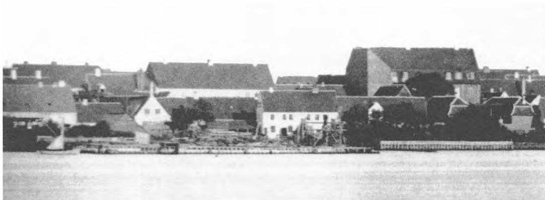
E. C. Benzons skibsværft i Nykøbing Falster. Til venstre ses Benzons privatvilla, mens de tre næste bygninger huser selve værftet. (Handels- og Søfartsmuseet).
