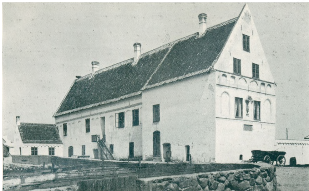
Fig. 5. Östra längan från väster. Det bredare byggnadspartiet med den spetsiga gaveln är återstoden av gamla huvudbyggnaden.
