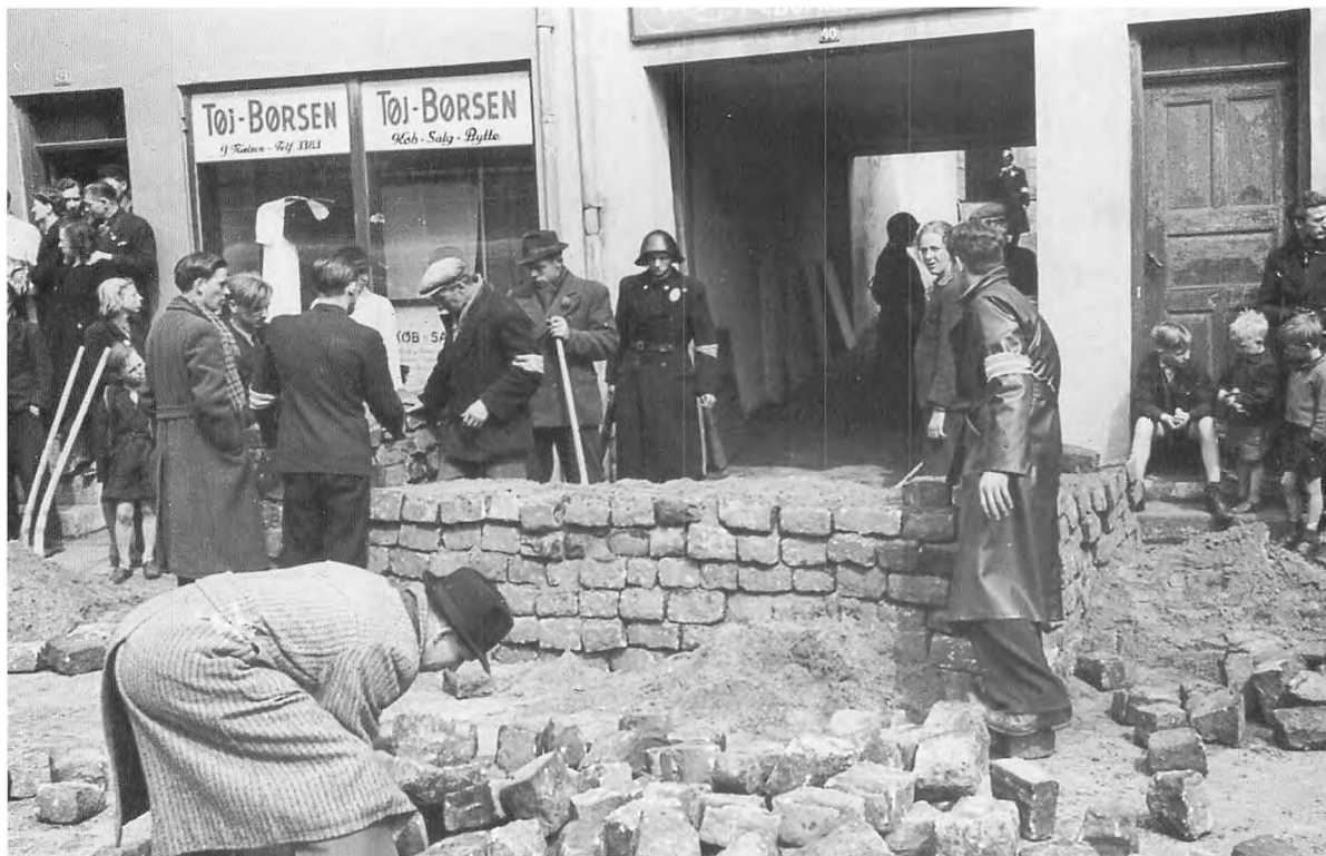
Mandskabet fra modstandsbevægelsens arbejdsafdeling er her i gang med at bygge en barrikade foran Åboulevard 40, der var en af adgangsvejene til Koncertpalæet. Flere andre steder i byen fandt tilsvarende byggerier sted.
