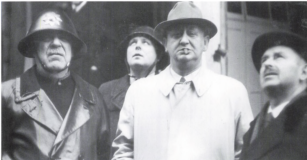
Borgmester E. Stecher Christensen blev nøje orienteret om, hvad der skete i byen, stort som småt. Ofte mødte han selv op for at bese skaderne, sådan som her, hvor han sammen med bygningsinspektør Kr. Møller ser på skader i Søndergade. Foto i Lokalhistorisk Samling.
