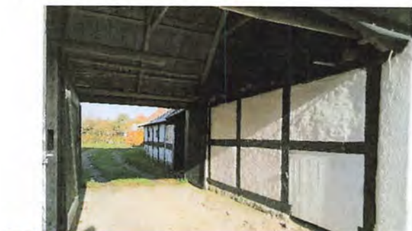
Nogle af de gamle bygninger
