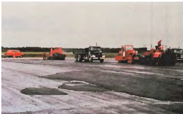
Asfaltudlægning på Tirstrup Flyveplads 1984
