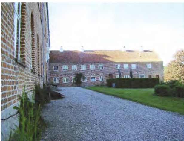
Sydfløjen, den nordlige fløj med tingstue blev nedbrudt i 1857
