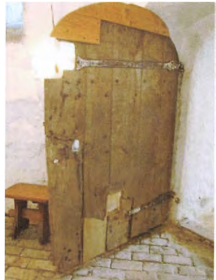
Kælderdør i fangekælderen på Rugaard
