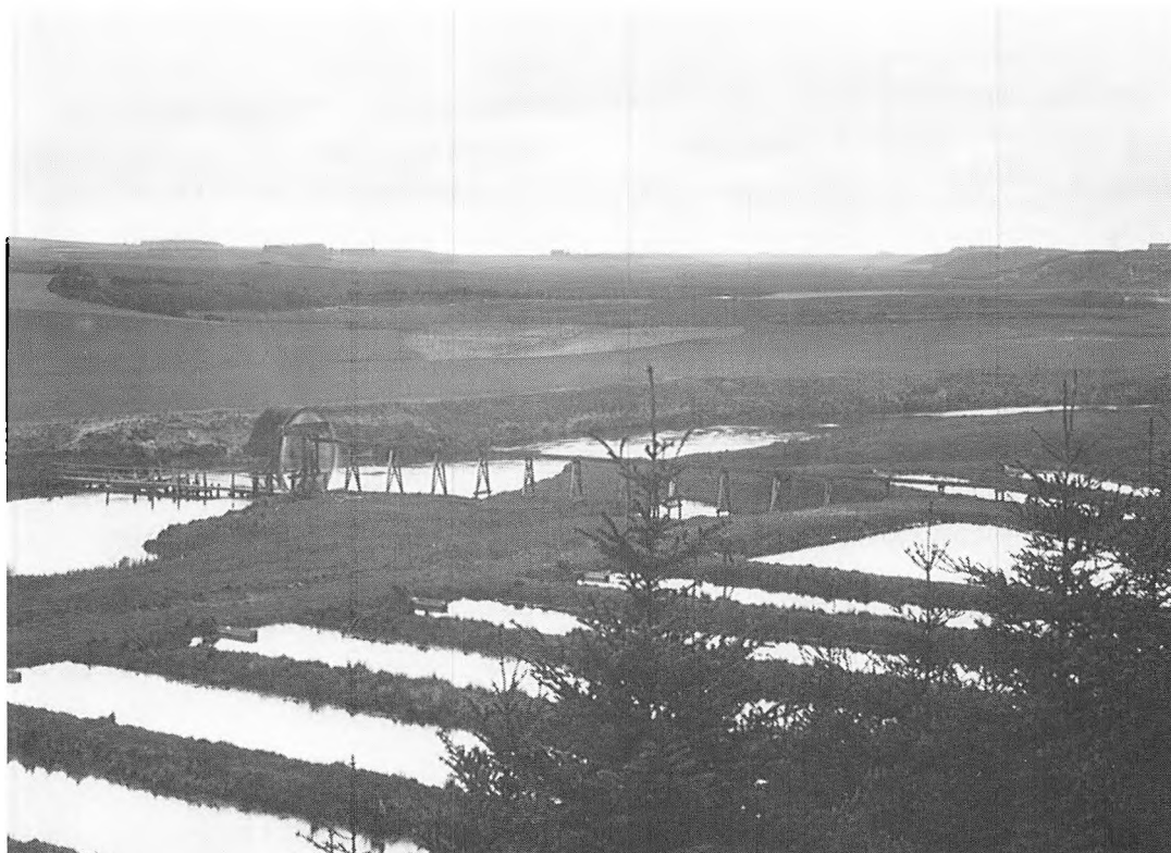
For at udnytte engarealerne langs med Storåen etableredes vandingsanlæg, hvor store vandhjul løftede åens vand op i render, der førte det ind over engene. Også i Naur var der i 1800'erne flere af disse store vandhjul. Billedet her viser et sådant anlæg ved Frøjk omkring århundredskiftet. (Lokalhistorisk Arkiv Holstebro Kommune).
