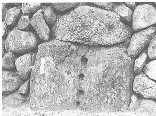
Kvadersten i diget ved Naur kirke. Stammer formodentlig fra kirkens opførelsestidspunkt, hvor man åbenbart har forsøgt at kløve stenen. (Foto: Torben Skov).
