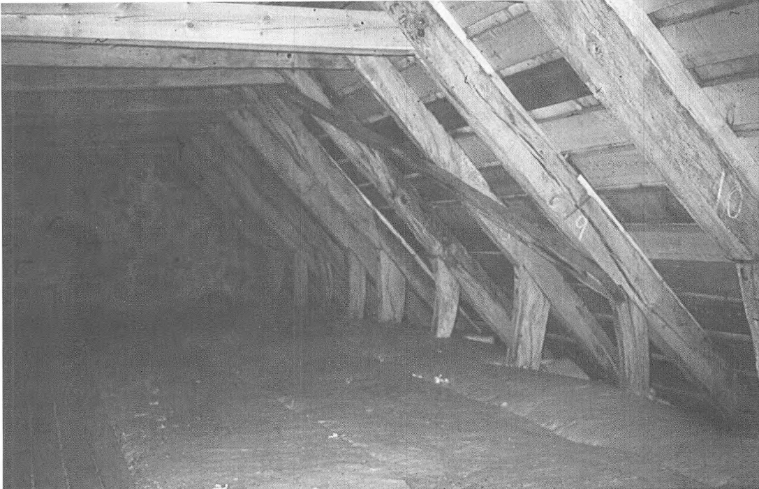
På loftet over Naur kirkes skib findes en smuk tagkonstruktion, hvis ældste dele at dømme efter den grove tilhugning må være af anseelig alder. Måske nogle af disse bjælker for århundreder siden er hentet af naurfolkene nede i Loversyssel?
