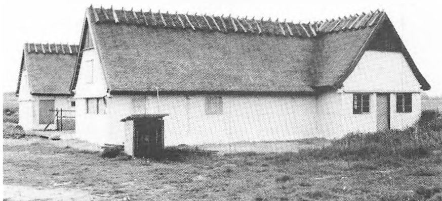
Sommeren 1990. Bygningen hvidkalkes med lagret kulekalk over tømmer og murtavl på nordsjællandsk vis. En del af træværket behandles med gammeldags træ tjære, specielt importeret fra Gotland i Sverige. De første vinduer isættes.
