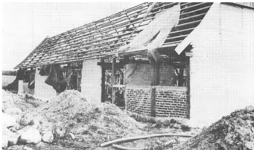
Rejsegilde i december 1988 på stuelænge og staldlænge. Tømmeren er færdig med bindingsværket og taget er klar til tækkemanden. Udmuring af bindingsværktavlene påbegyndes i traditionelle kulbrændte mursten - de sidste, der blev fremstillet på Borup Teglværk.
