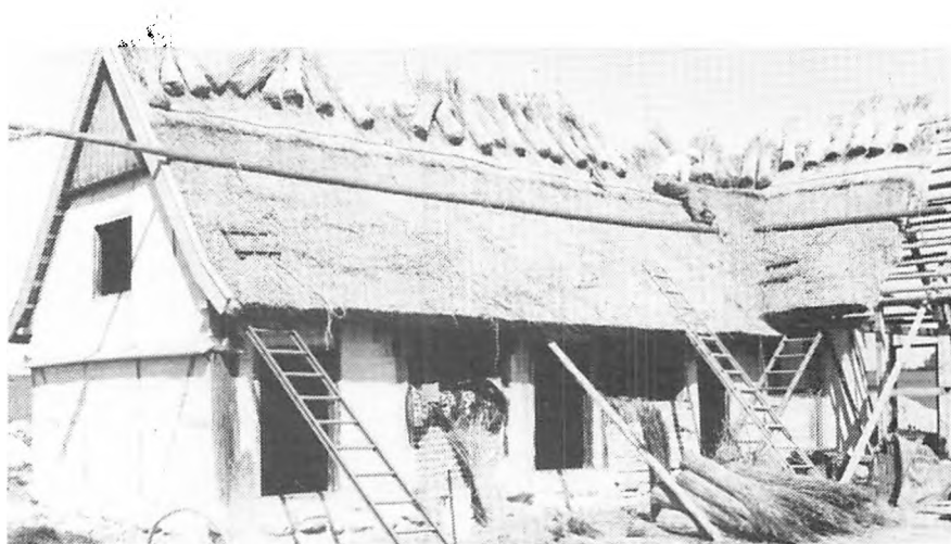
Sommeren 1989. Ladelængen er rejst, og de fleste vægge opmuret. Tækkemanden arbejder med det specielle nordsjællandske rørtag. Traditionen byder, at rørene fastholdes af lange hasselkæppe, som bindes til taglægtierne. Forud ligger et større arbejde med at fremskaffe de rigtige hasselkæppe. Den store åbne køkkenskorsten særdiggøres i løbet af efteråret.
