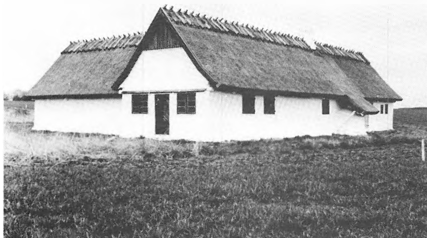
Sommeren 1992. De udvendige døre, såkaldte revledøre, fremstillet som traditionelt håndarbejde isættes i de tre længer. Stuelængens håndhøvlede bræddeløfter opsættes. Til alt tømmer- og snedkerarbejdet bliver der anvendt håndsmedede søm, som var almindelige indtil for hundrede år siden.
