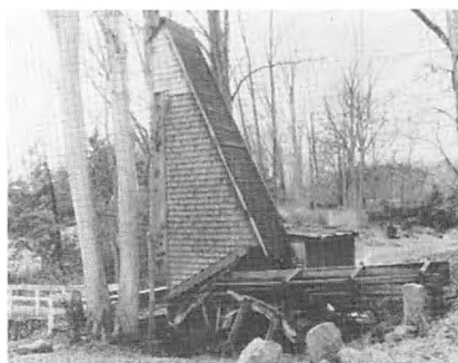
Fig.5 Donse krudtmølle. Møllebygningen, fra 1800-årene er opført i en spånklædt tømmerkonstruktion med et stort overfaldshjul, der idag fremtræder som delvis ruïn. Mølleområdet rummer også det gamle beboelseshus for krudtmesteren. Bygningen var beskyttet af høje jordvolde i tilfælde af eksplosion ved formalingen af krudtet.
