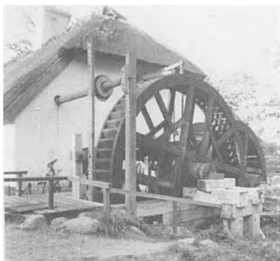
Fig.4 Hammermøllen i Hellebæk. Møllebygningen der blev opført i 1765 er forsynet med to store vandhjul. Det høje smalle hjul driver ved en vægstangsordning de to blæsebælge til essen. Det lavere og bredere hjul driver de to "vandhamre" som blev brugt til smedning af det glødende jern. Geværfabrikken blev nedlagt i 1870 og det nuværende hammerværk er en rekonstruktion fra 1982.
