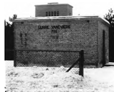
Gurre Vandværk blev opført på privat initiativ i 1956 - til forsyning af Gurrens beboere. men alligevel indgik vandværket i planlægningen for Gurre.
