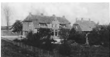
Hornbæks nye skole opført 1911-12. Huset til højre var førstelæreren bolig.
