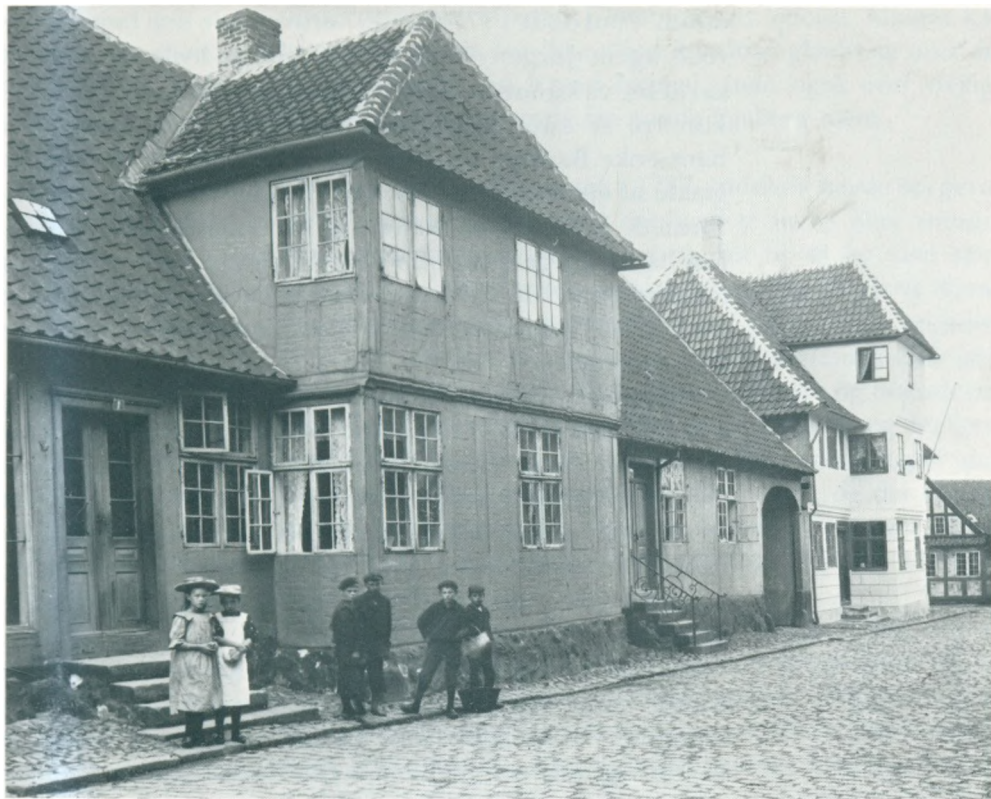
Holkegade 1, »Den gamle Gård«, og Holkegade 3 fotograferet i 1908. Gaden har ikke forandret sig stort siden da, men man bemærker, at »Den gamle Gårds« bindingsværk er overhalket og at Holkegade 3 allerede på det tidspunkt har fået sin facade overpudset. Det klæder egentlig begge bygninger (fot. M. Mackeprang, Nationalmuseet).
