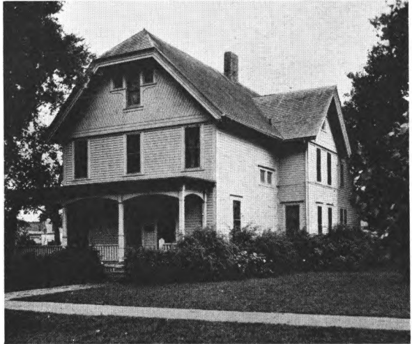
Fredrik Bruns hus i Blue Earth, Minnesota, U. S. A.
