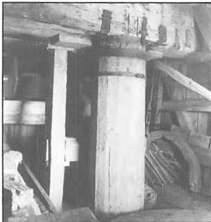
Pibe mølles indre. Den lodrette kraftige træstolpe er stubben. Oven på denne hviler den svære, vandret liggende stenbjælke.
