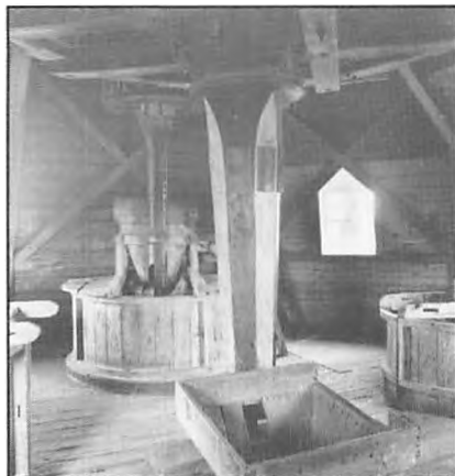
Melby mølles indre. Kværnloft med tre kværne og et stort stjernehjul (overst) på en kraftig lodret aksel.
