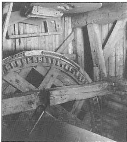
Pibe Mølle. Kværnloft med hattehjul og vingeaksel. (Foto F.B. 1988)
