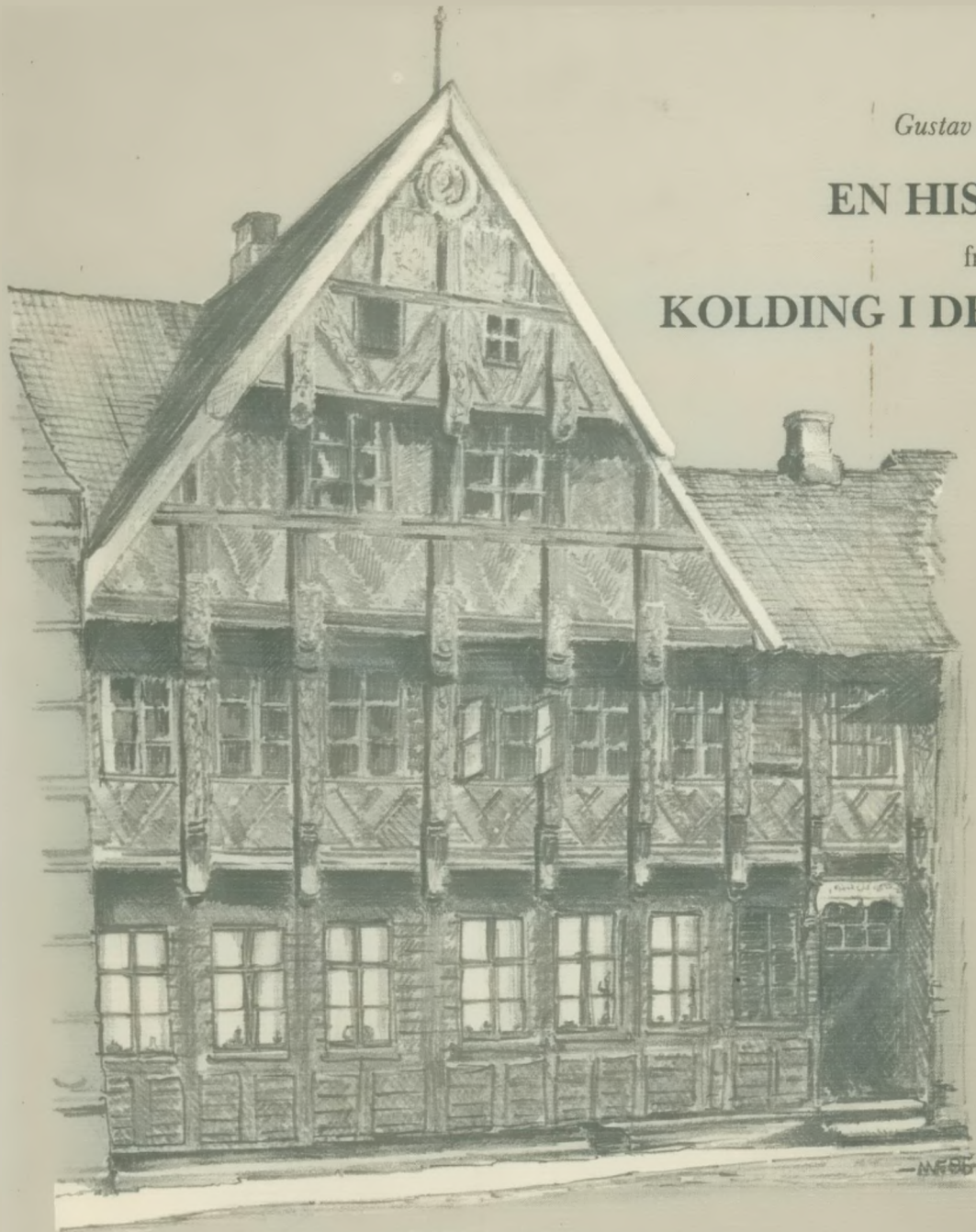
Forhuset til Borchs gård, beliggende i Torvegade.
