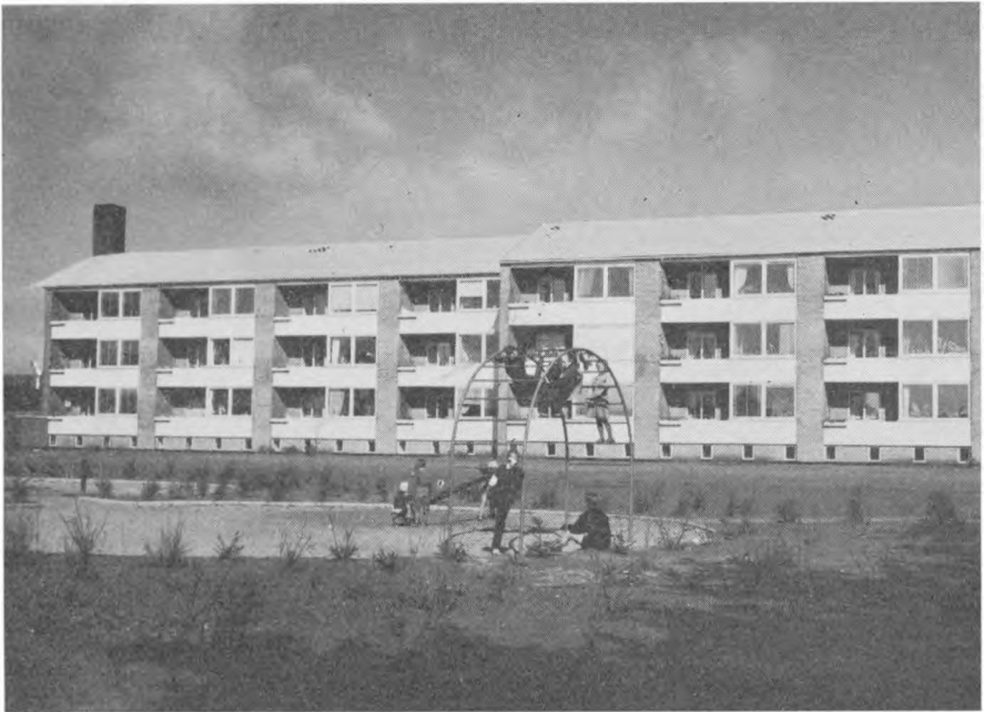
Boligforeningens Bygning »Kronager«.
