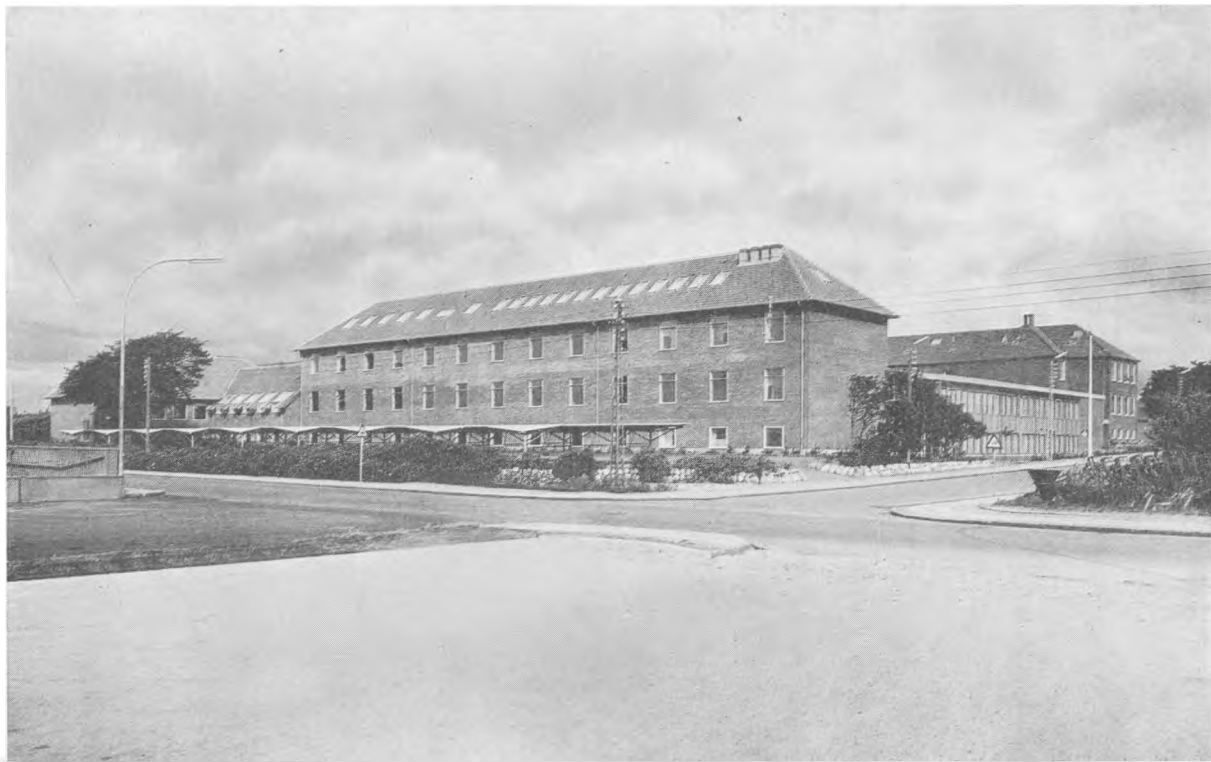
De nye Skolebygninger ved Skolevængset set fra Enghavevej. Den gamle Skolebygning ligger helt skjult i Billedets Baggrund.
