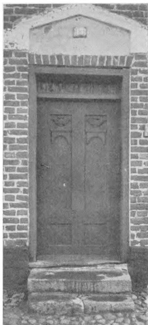
Indgangsdør Øster Strandgade 13. (Fotografi ca. 1920. Nationalmuseet).
