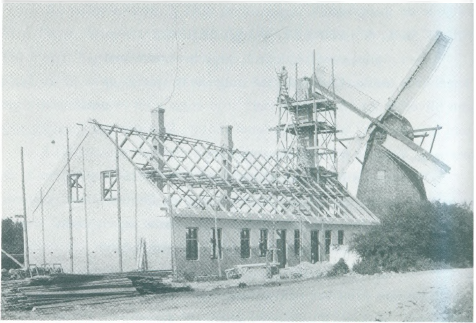
Det stråttægte bageri ved Blakke mølle brændte i 1914. Her bliver det nye bageri, som afløste det, bygget.
